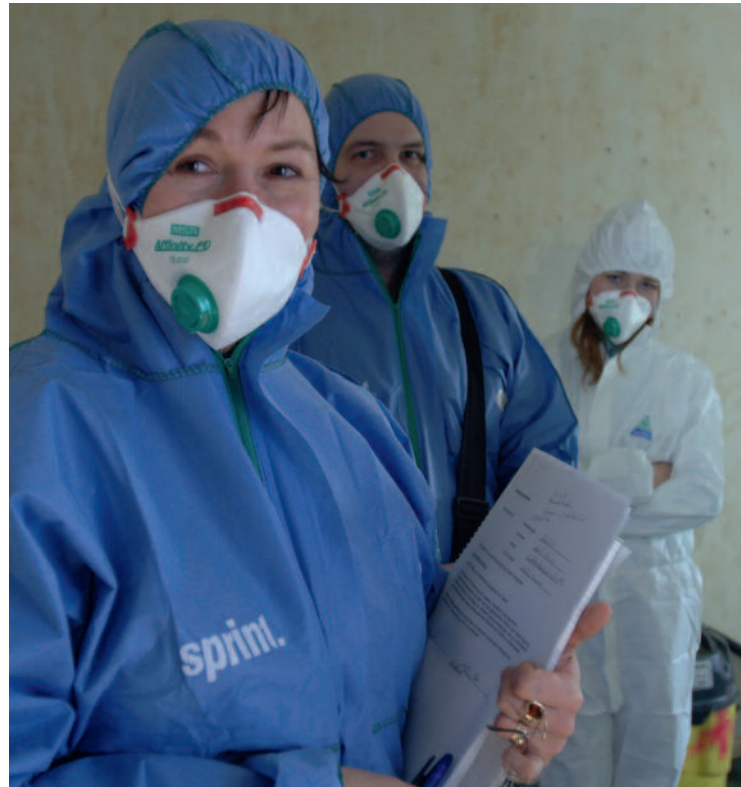
Mitarbeiter des R+V-Sanierungsspezialisten Sprint bei ihrer Arbeit in einem beschädigten Gebäude.
