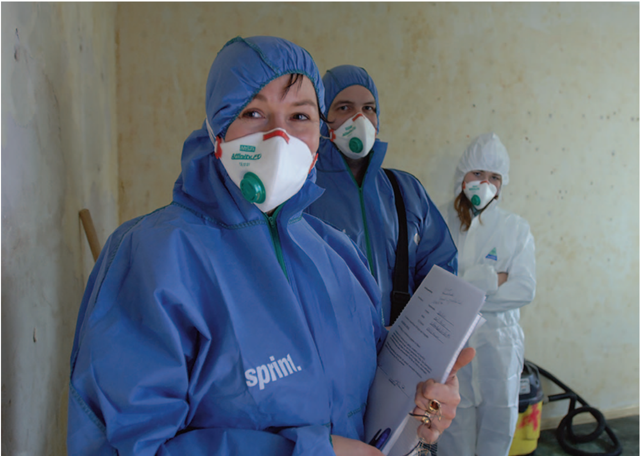
Mitarbeiter des R+V-Sanierungsspezialisten Sprint bei ihrer Arbeit in einem beschädigten Gebäude.
