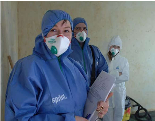
Mitarbeitende des R+V-Sanierungsspezialisten Sprint bei ihrer Arbeit in einem beschädigten Gebäude.
