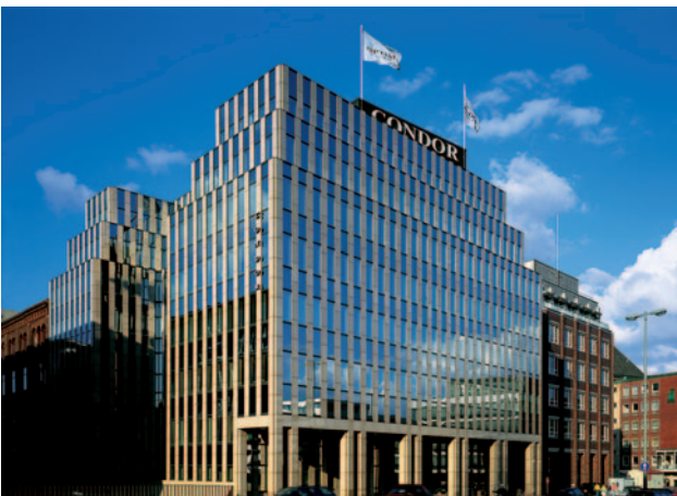
Das Gebäude der Condor Versicherungen in Hamburg. Condor ist der Maklerversicherer von R+V.
