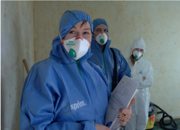
Mitarbeiter des R+V-Sanierungsspezialisten Sprint bei ihrer Arbeit in einem beschädigten Gebäude.
